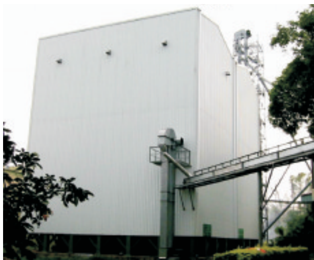
圖 8. 鋼板方型筒倉（中央直立物為箕式輸送機）
