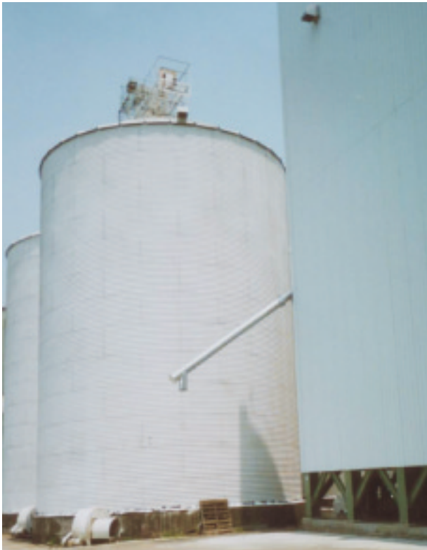
圖4. 鋼板圓筒倉（平底，左下角為常溫離心式送風機，右側為鋼板方型筒倉）
