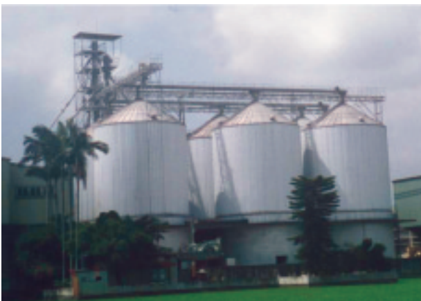
圖5. 鋼板圓筒倉（上方為垂直型箕式輸送機和橫式進料螺旋輸送機）
