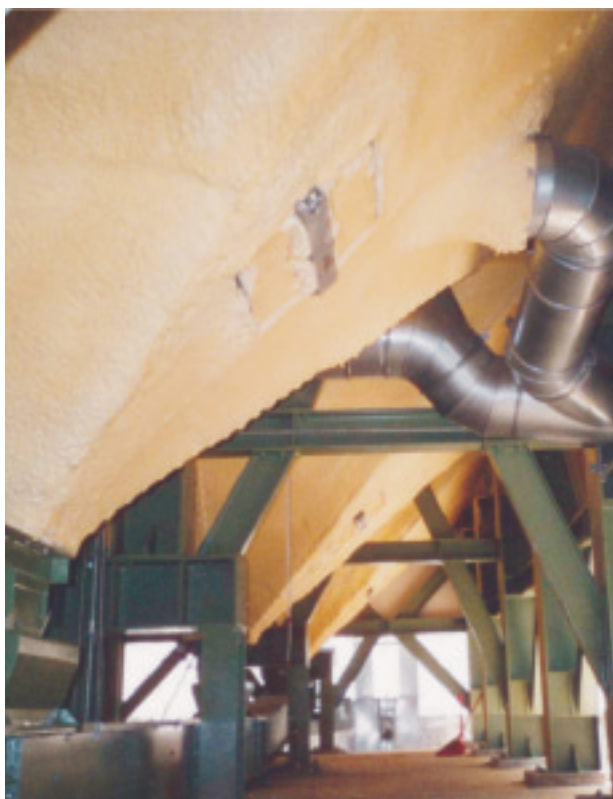
圖 16. 鋼板方型筒倉倉底通風管（右上角）和倉底出料螺旋出送機（左下角）
