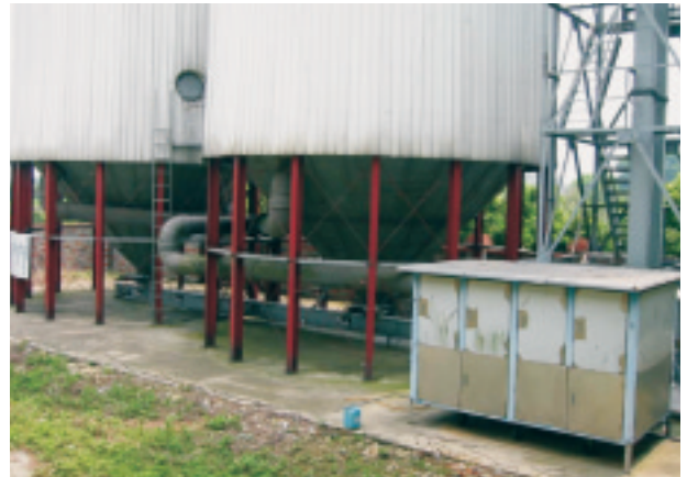
圖6. 鋼板圓筒倉（錐形底右下角為冷藏機組）
